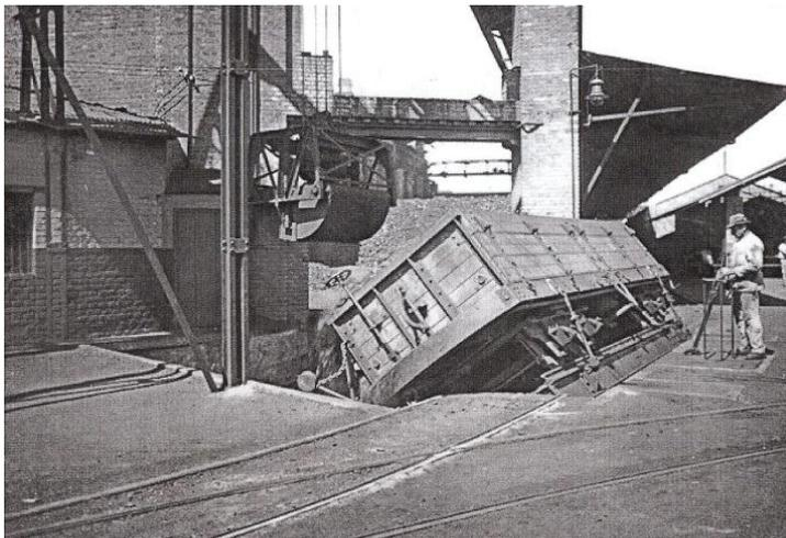
Figura 4.33 – Casa das Retortas – Descarga de um vago de carvão e o sistema elevatório que removia do fosso par o depósito. Fonte: Memorial Básico de Restauro. Arquiteto Paulo Bastos e Associados.
