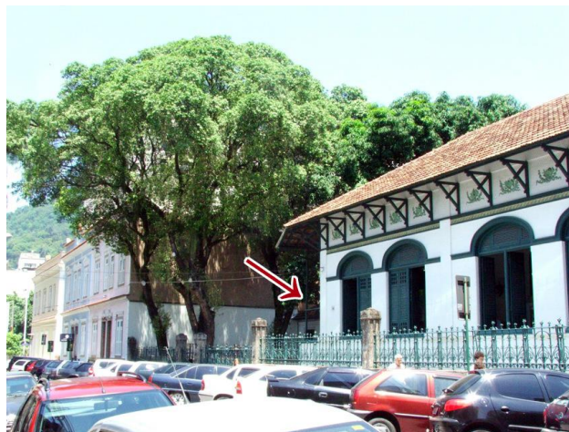
3.3.b. Fachada ao lado da entrada (Fonte: Banco de imagens grupo INFOC)
