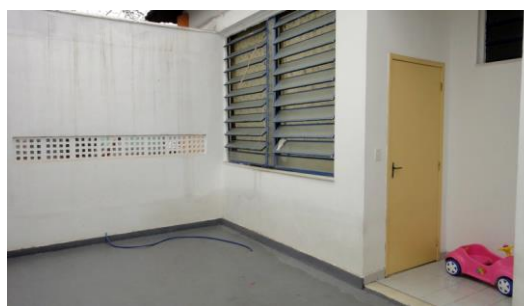
3.7.g.Vista interna do pátio adjacente à sala (Fonte: Banco de imagens grupo INFOC)
