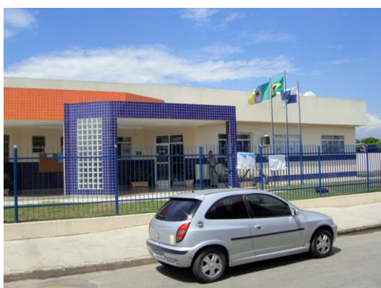
3.1.a. Vista externa da escola (Fonte: Banco de imagens grupo INFOC)
