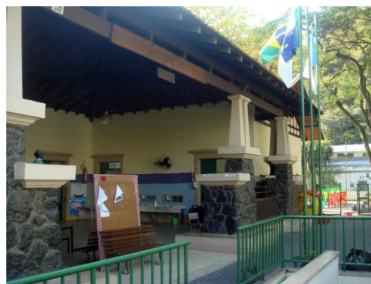
3.2.c.Rampa e escada de acesso
