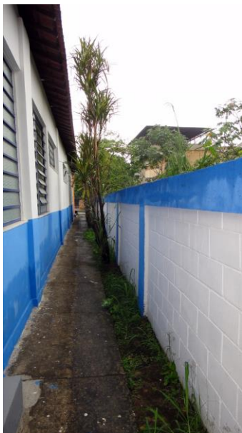
3.7.h. Corredor na lateral direita da escola (Fonte: Banco de imagens grupo INFOC)
