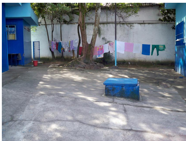
3.6.f. Pátio atrás da escola (Fonte: Banco de imagens grupo INFOC)
