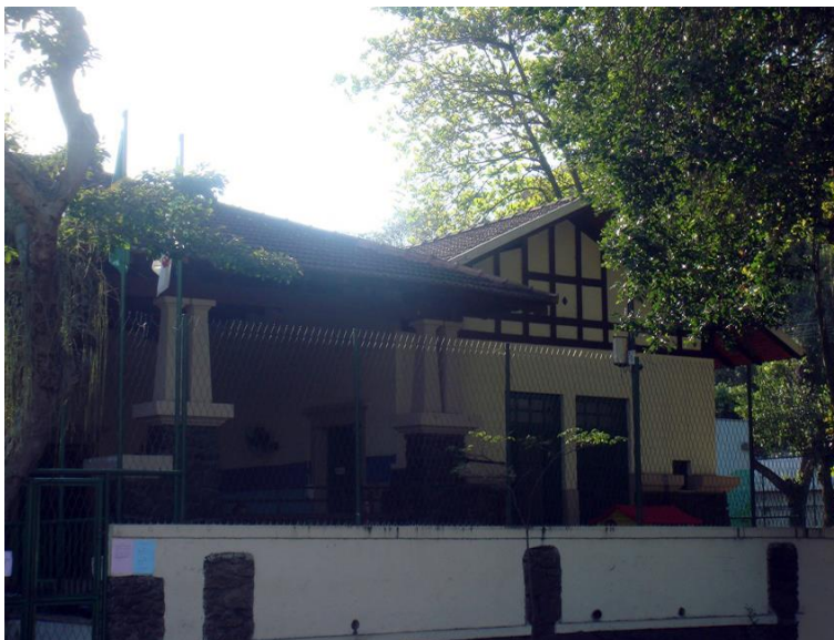
3.2.a.Fachada da escola
