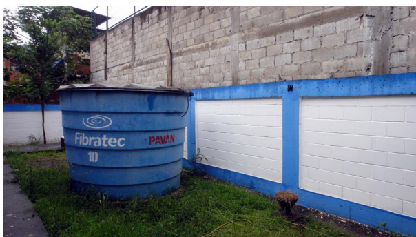
3.7.i. Cisterna no pátio dos fundos (Fonte: Banco de imagens grupo INFOC)
