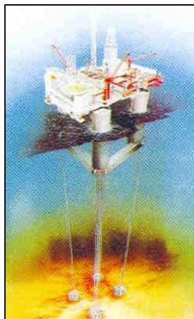
Figura 2.12: Plataforma *TensionLeg*
