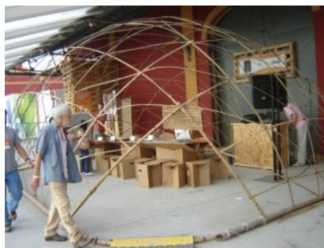
Figura 94: Vista interna do canto onde será aberto o vão de entrada, observando o reforço em fitas de bambu numa das laterais. Estrutura já com o vão aberto.
