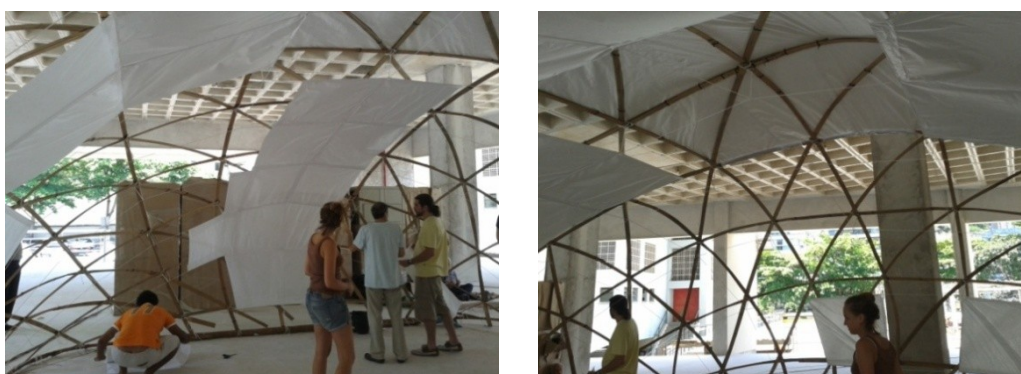
Figura 101: Colocação de gomos de papel para simulação de vedação.
