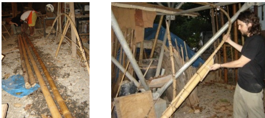
Figura 92: Colmos de mossô sendo tratados pelo pesquisador Daniel Malaguti para formar a base. Arco de fitas de bambu, que compõe os cantos, fixado ao colmo com amarração em torniquete.
