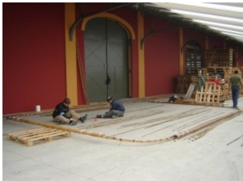
Figura 93: Amarração para compor as fitas maiores e a estrutura já montada. (CORREIA DE MELO, RIPPER, RIPPER e TEIXEIRA FILHO, 2012).
