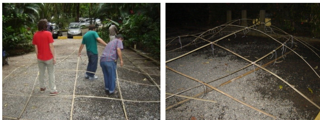
Figura 90: Amarração da trama, percebendo-se a deformação pela junção dos cruzamentos.
