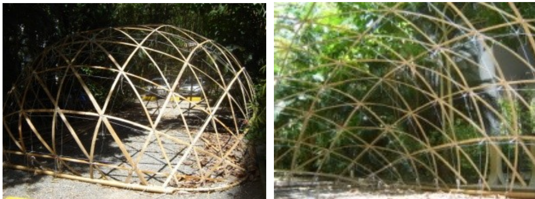
Figura 99: Estrutura montada com fitas abertas em esterilha e com rede de cabos.
