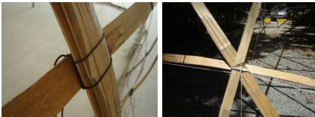
Figura 98: Fitas amarradas. Na imagem à esquerda temos a superposição de uma fita emendada. Na imagem à direita temos a amarração do cruzamento de fita diagonal e amarração complementar para a rede de cabos.
