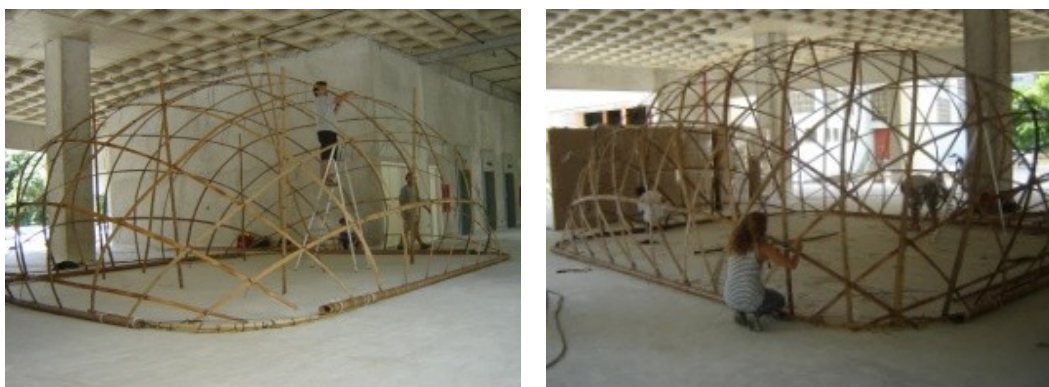
Figura 100: Estrutura em montagem no pilotis, vendo-se na imagem à esquerda os gabaritos de altura ainda posicionados.
