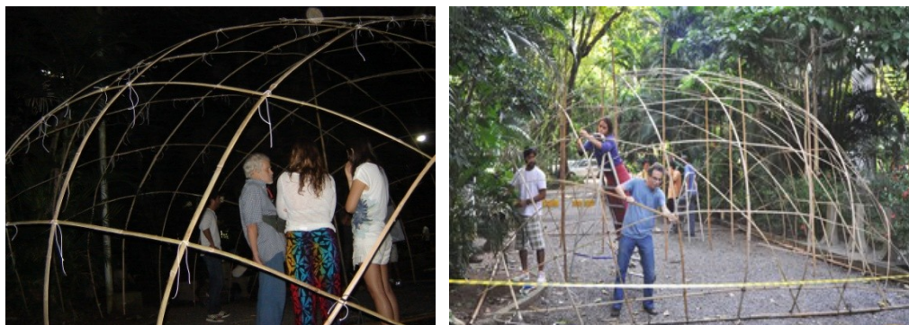
Figura 91: Estrutura erguida vendo-se as sobras de cordas em cada nó. No dia seguinte, cruzamento das fitas diagonais, sem amarração. Os gabaritos de altura – varas na vertical – ainda estão locados nos cruzamentos mais altos da malha.
