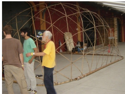
Figura 93: Amarração para compor as fitas maiores e a estrutura já montada. (CORREIA DE MELO, RIPPER, RIPPER e TEIXEIRA FILHO, 2012).
