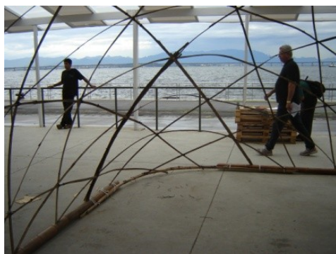
Figura 94: Vista interna do canto onde será aberto o vão de entrada, observando o reforço em fitas de bambu numa das laterais. Estrutura já com o vão aberto.
