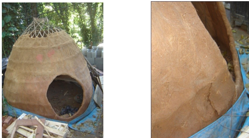
Figura 20: Cúpula catenária no canteiro experimental do CAU da PUC-Rio.
