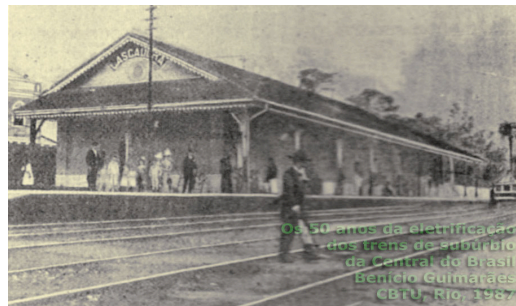
Figura 10 - Estação de Cascadura inaugurada em 29 de Março de 1858. Fonte: http://vfco.brazilia.jor.br .
