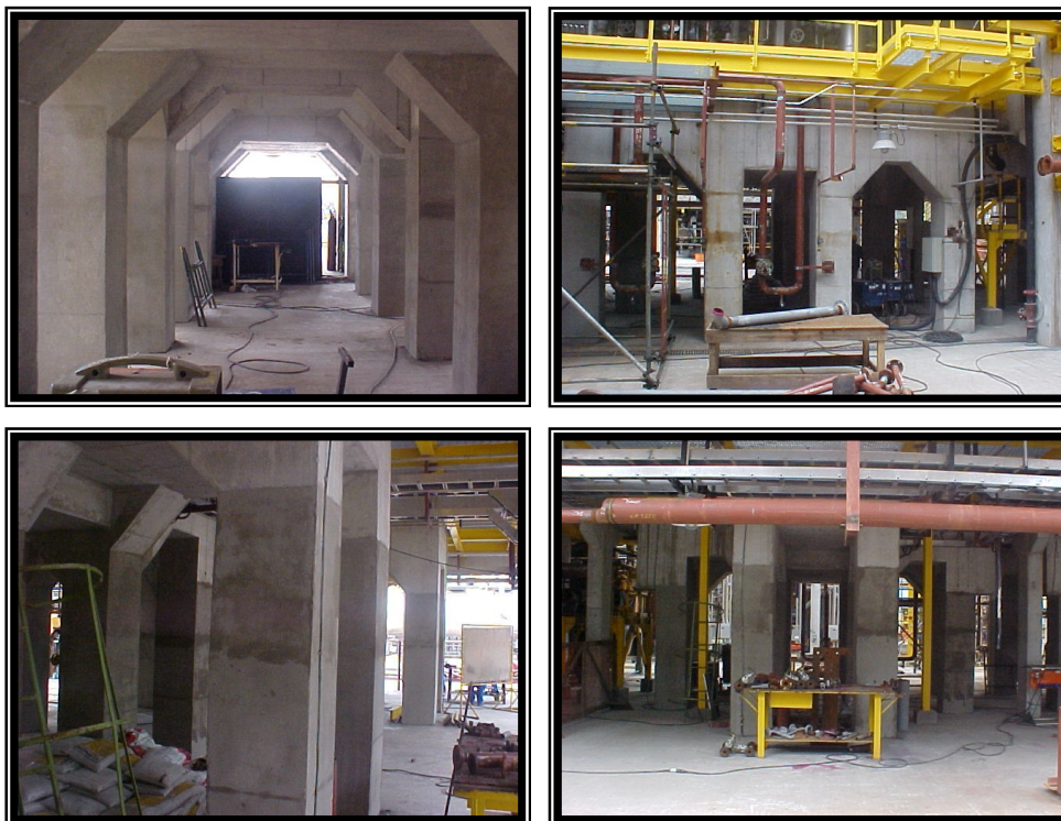
Figura 3-5 – Fotos da estrutura de concreto armado real (modelo físico)
