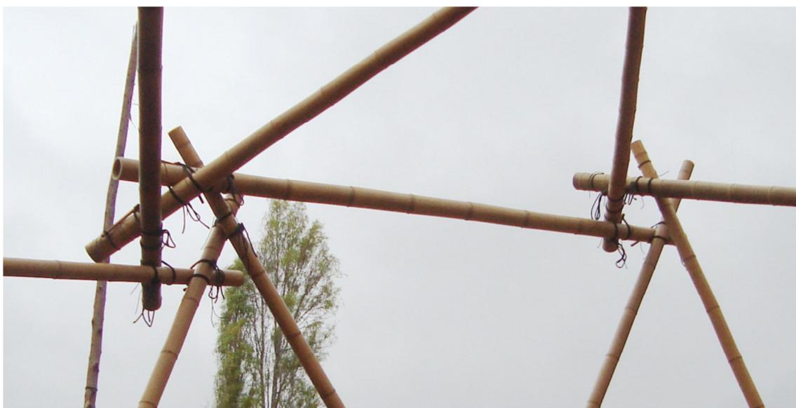
Figura 83 - bambu em giro, detalhe para as extremidades em posições diferentes
