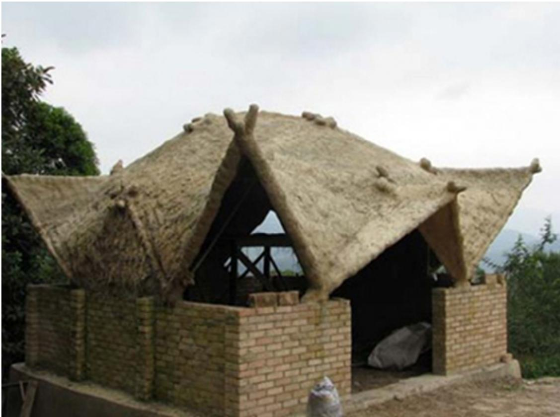
Figura 134 - Domo barreado sem reboco
