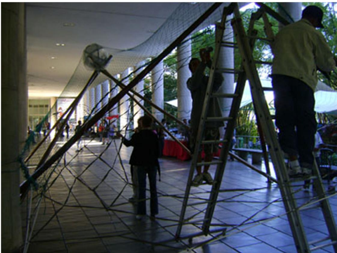
Figura 103 - Experimento de montagem de parte da estrutura de bambu com rede em escala 1:1
