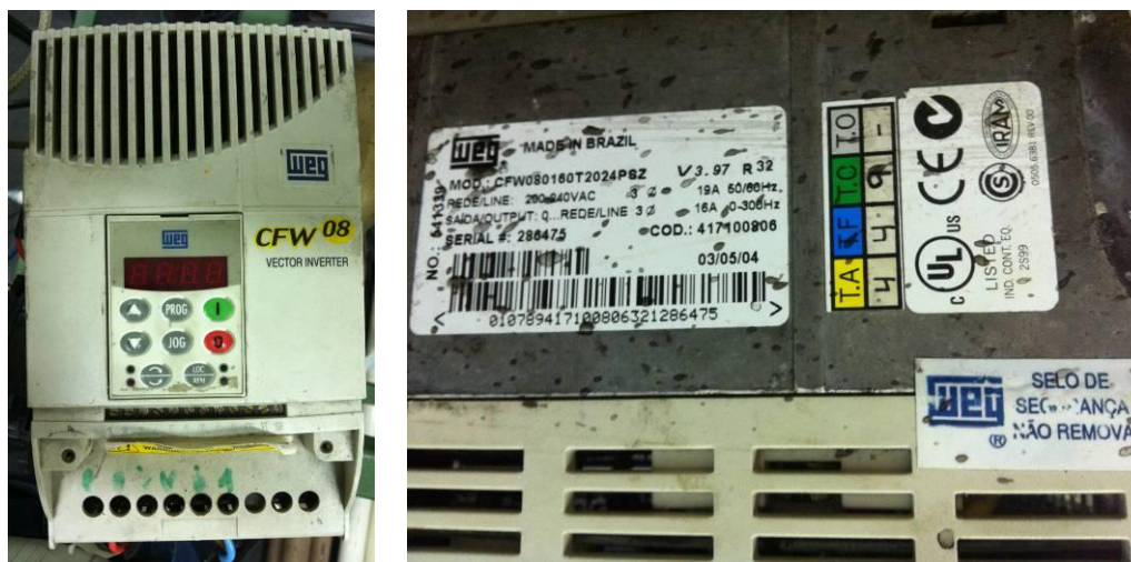
Figura 5.6 – Inversor de frequência utilizado no controle da rotação da bomba.
