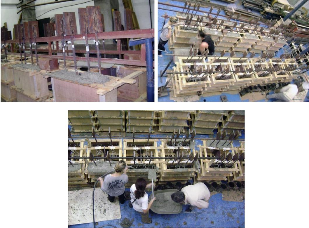
Figura 5.56 – Concretagem dos ensaios
