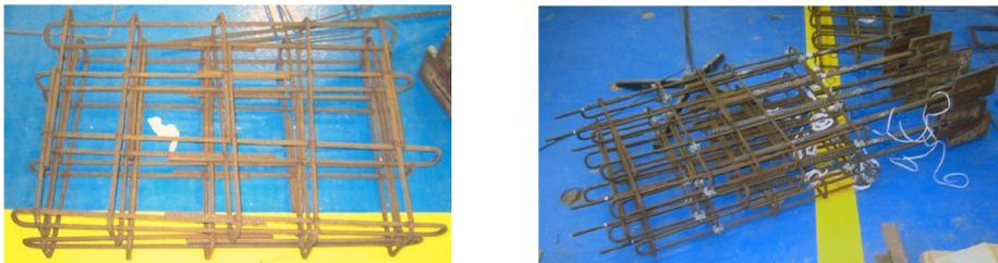
Figura 5.34 – Montagem das armaduras
