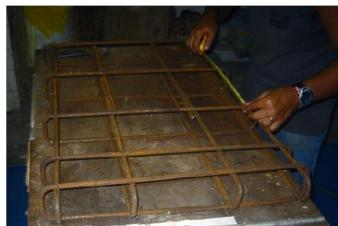
Figura 5.7 – Armadura dos estribos
