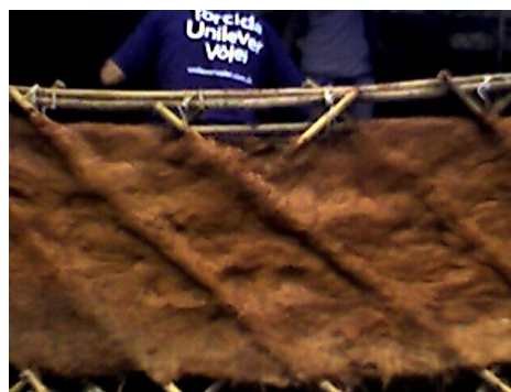
Figura 57 e 58 – Pantográfica “Fibrobarreada” quase pronta
