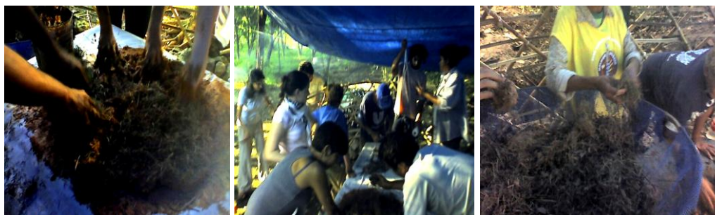
Figuras 41, 42 e 43 – Agregando capim ao barro
