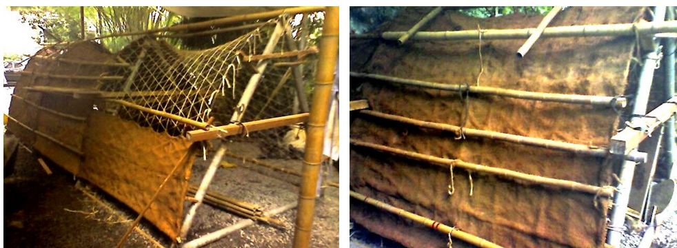
Figuras 61 e 62 – Estrutura do túnel sendo “Fibrobarreada”
