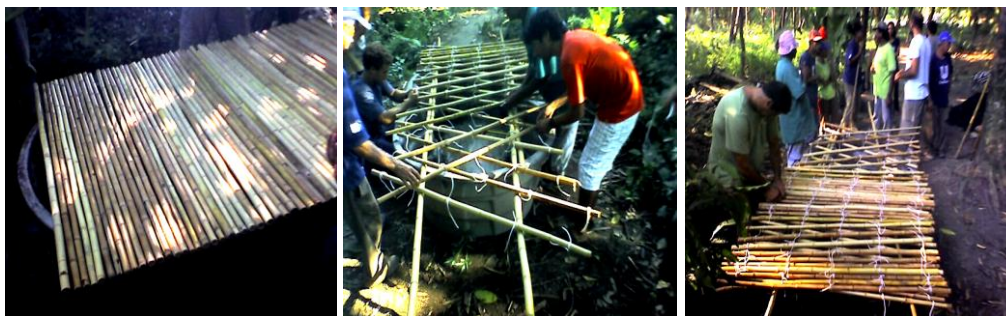
Figuras 23, 24 e 25 – Pantográfica em construção
