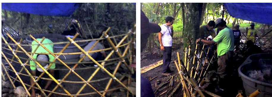
Figura 32, 33 e 34 – Fixando e ajustando a pantográfica
