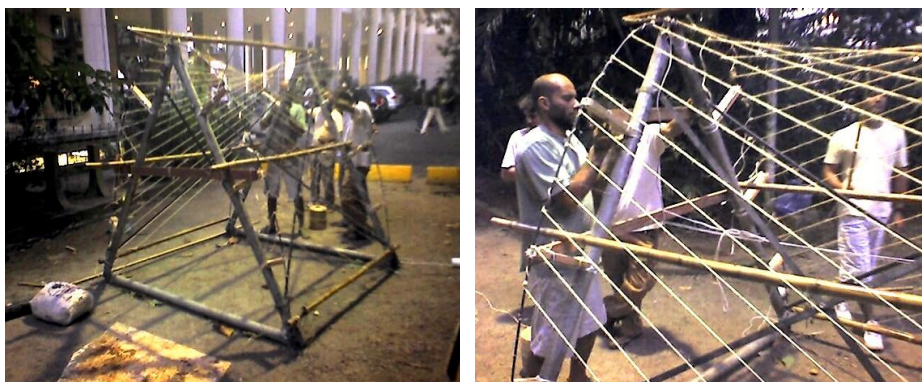
Figuras 59 e 60 – Início da construção do túnel
