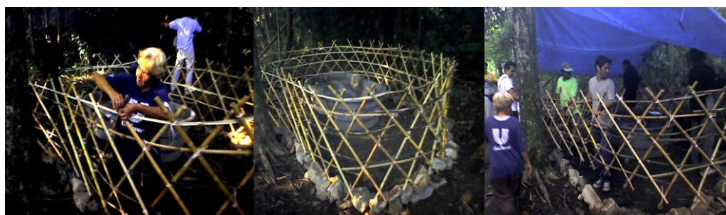
Figuras 29, 30 e 31 – Reforço das amarrações da estrutura
