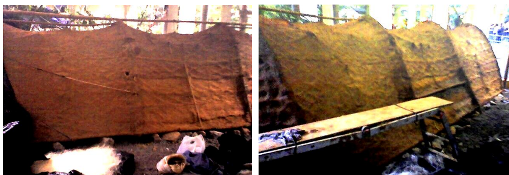
Figuras 63 e 64 – Túnel de “Fibrobarro” semi pronto
