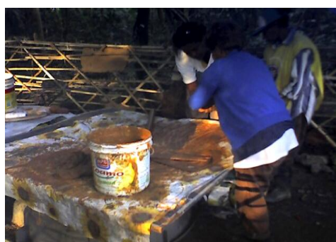
Figura 50 – Equipe do Anil preparando o “Fibrobarro”
