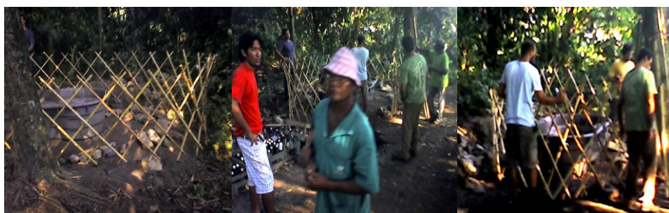
Figuras 26, 27 e 28 – Ajuste da pantográfica no local
