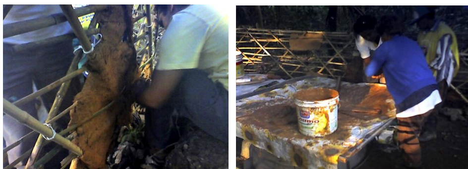
Figura 49 – “Barreando” a trama
