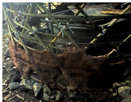
Figura 52 – Pantográfica sendo “Fibrobarreada”
