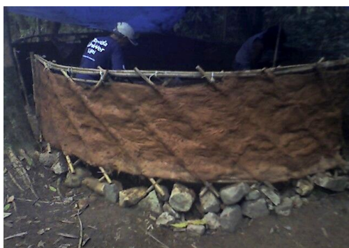
Figura 57 e 58 – Pantográfica “Fibrobarreada” quase pronta
