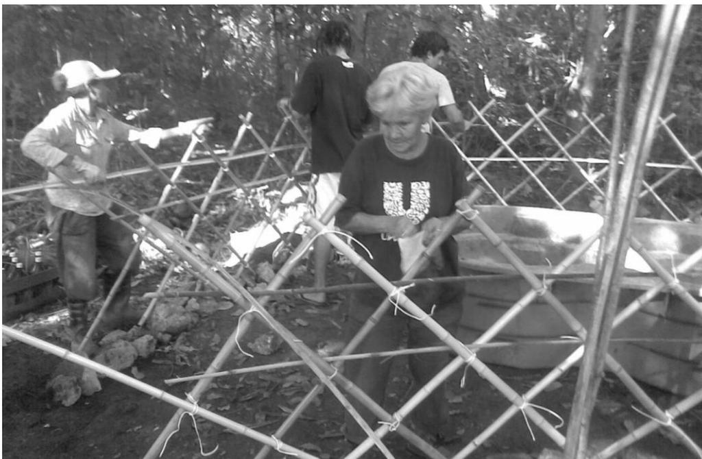
Figura 72 – Construção e fixação da treliça no local.
