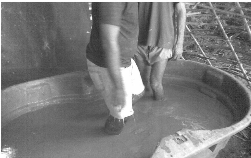
Figura 75 – Processo de amassamento do barro.
