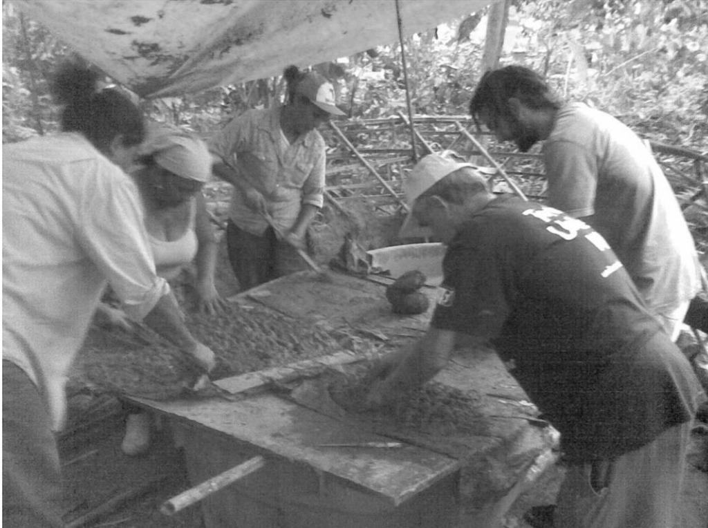
Figura 82 – O trabalho mais demorado é o de barreamento da estrutura.
