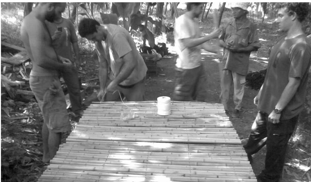
Figura 71 – Corte dos bambus para construção da treliça.
