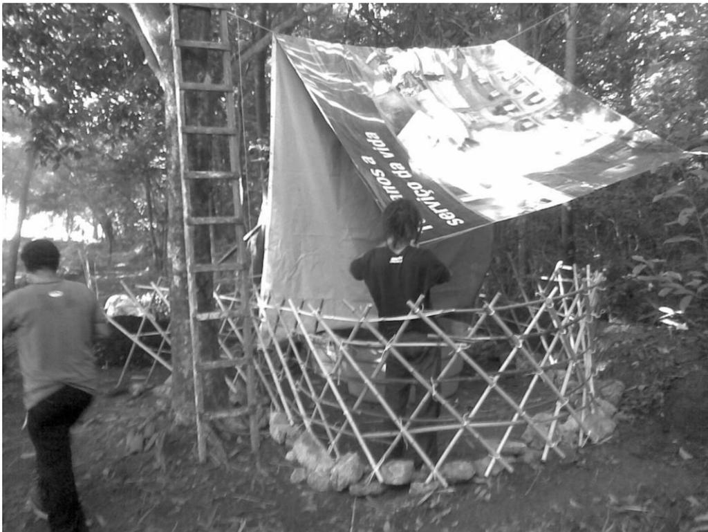
Figura 73 – Para proteger os bambus durante o trabalho, foi colocada uma lona provisória como cobertura.
