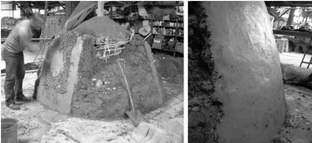
Figura 54 – Construção do molde e detalhe do acabamento final da casca de fibrobarro sobre molde de areia. (ALVARES, 2008, p.65)
