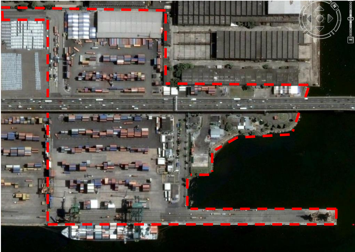
Figura 10: Vista superior do terminal 1 do porto do Rio De Janeiro
