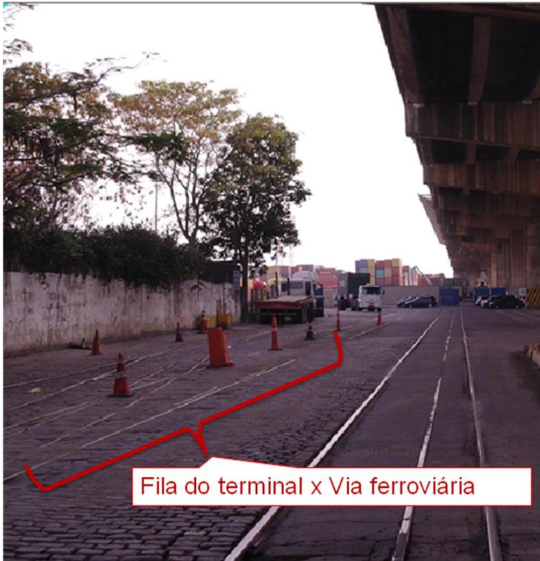
Figura 14: Espaço destinado a fila de carretas e a passagem da linha férrea
