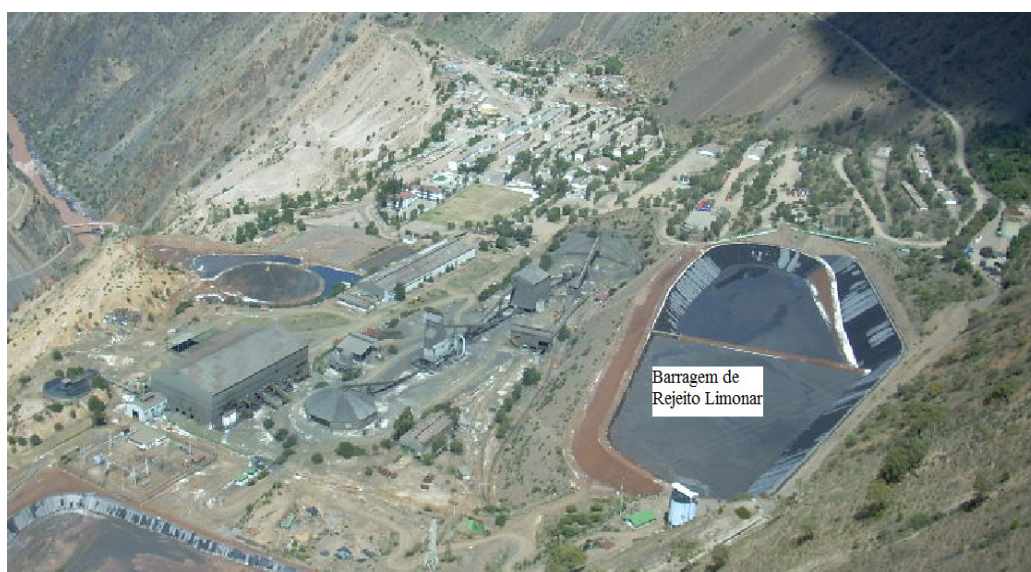
Figura 6.1 – Vista panorâmica da barragem de rejeito Limonar
