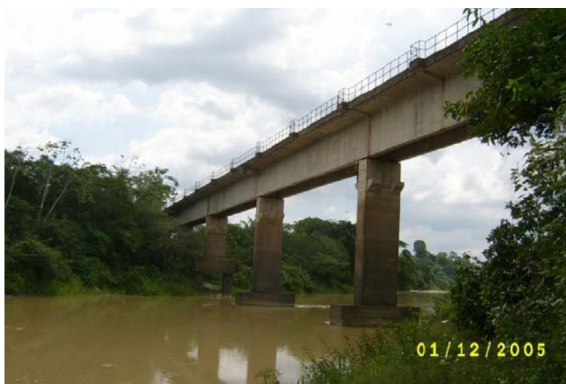
Figura 6.1. Vista geral da ponte sobre o Rio Vermelho (fonte: Relatório Técnico, Veloso et al 2007).
