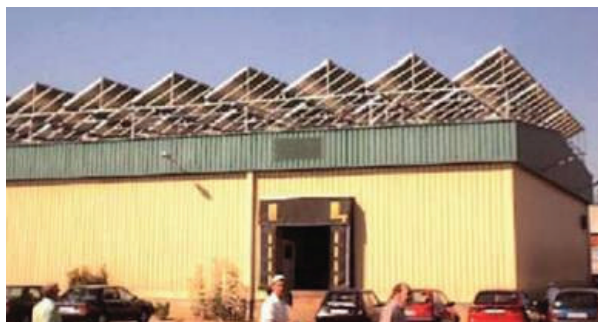
Figura 3: Coletores apoiados em suporte inclinados Fonte: Abrava.
