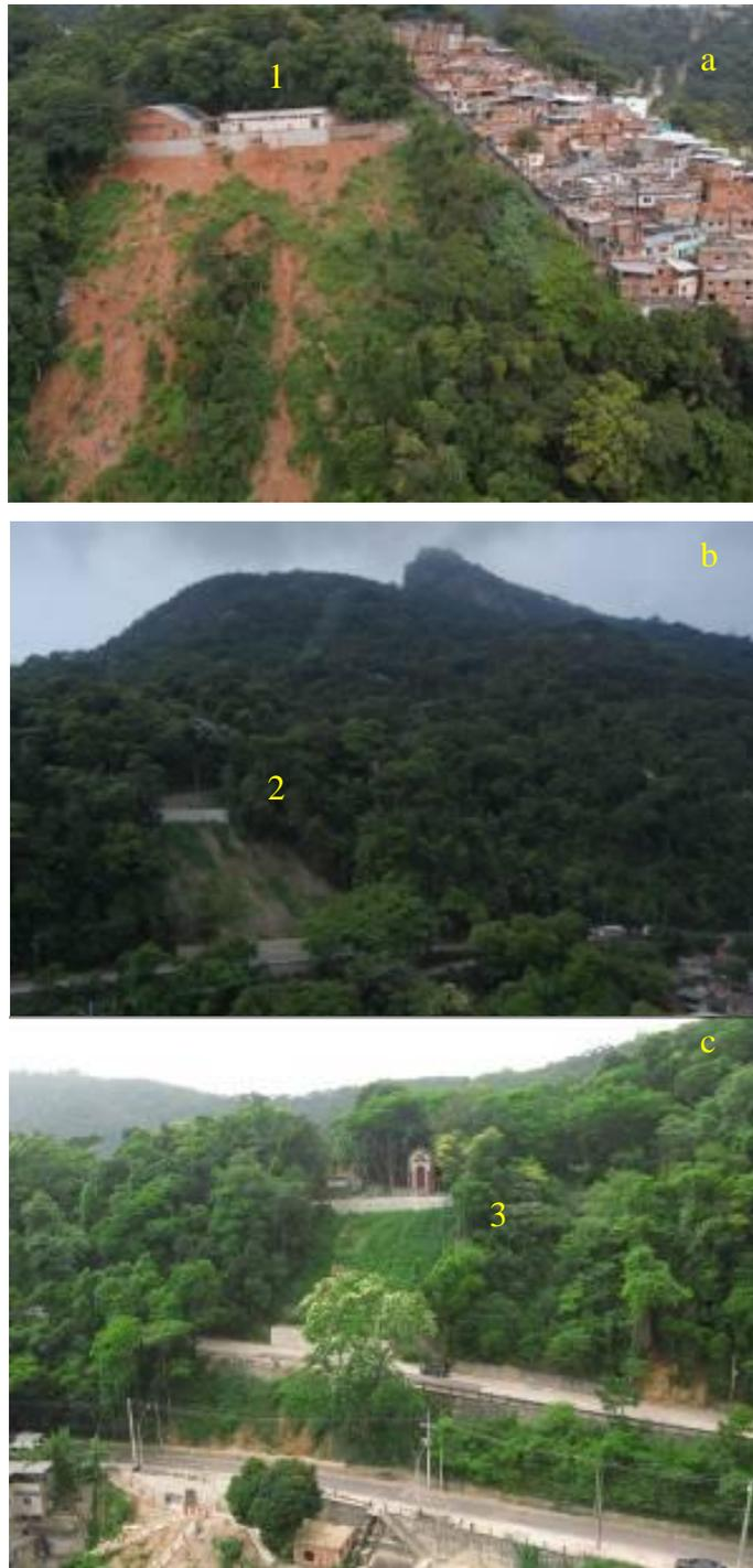
Figura 53 a, b e c: Fotografias oblíquas dos movimentos de massa localizados no Cosme Velho (1) e no Portal das Caboclas (2 e 3), observar nestas últimas as medidas de mitigação utilizadas.
