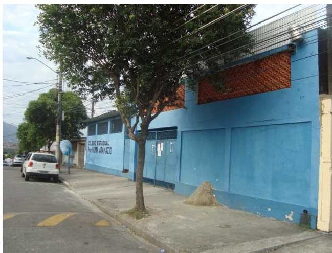
Figura 4: Vista da entrada da Escola do Monte
