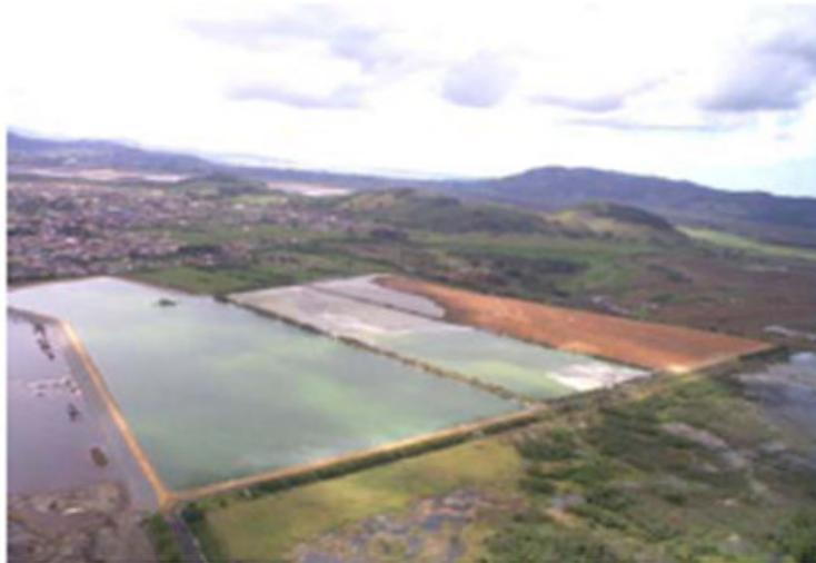
Figura 1.1 - Bacia de sedimentação de Cinzas do Complexo Termelétrico de Jorge Lacerda (Fonte: LEANDRO, 2005)
