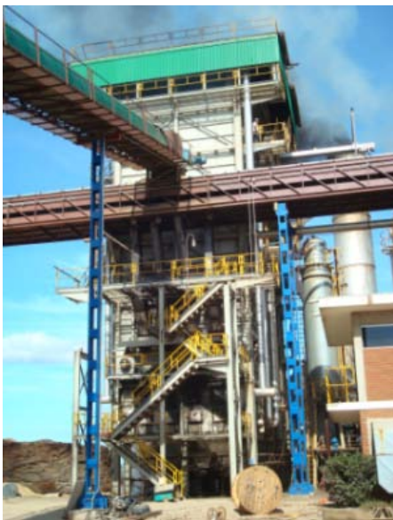
Figura 10. Caldeira de combustão do bagaço; fonte: Alcarde (2007)
