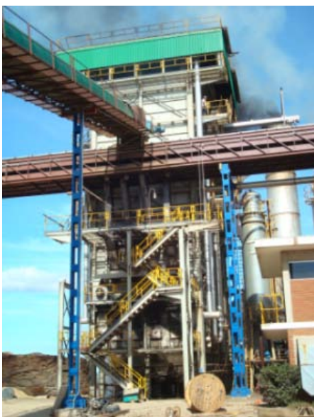
Figura 10. Caldeira de combustão do bagaço; fonte: Alcarde (2007)
