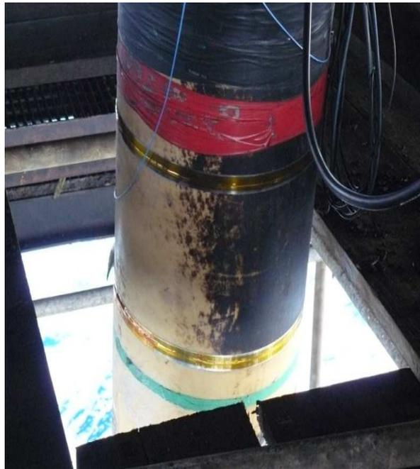
Figura 3. 2 - Colar instalado no *riser*.
