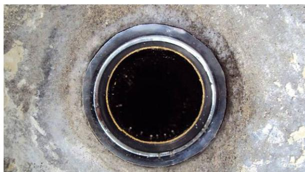
Figura 5.21 – Tampa utilizada para manter o *gravel pack*.
