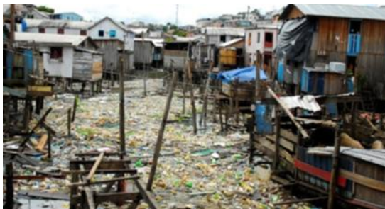
Figura 2- Habitações populares nas margens e leitos dos igarapés. Fonte: UGPI, 2010.
