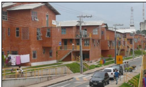
Figura 5- Moradia padrão construída pelo PROSAMIM. Fonte: UGPI, 2010.
