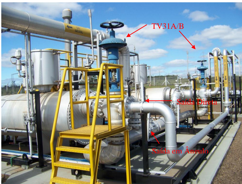
Figura 6.3– Válvulas Controle de Três Vias TV31A/B
