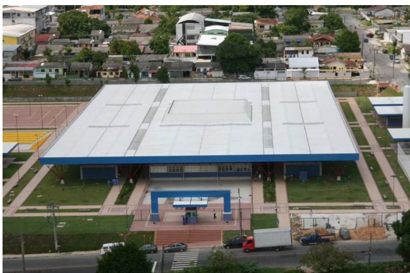
Figura 4- Detalhes da estrutura física do Centro de Convivência da Família Pe. Pedro Vignola e áreas adjacências - Vista frontal do Centro. Fonte: Portal Oficial do Governo do Estado do Amazonas, 2011.
