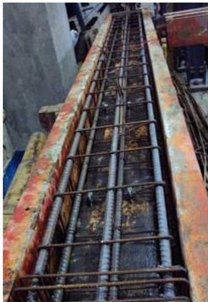
Figura 3.16 – Posição da armadura na forma metálica
