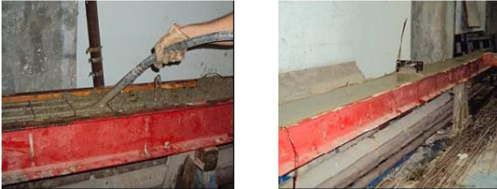
Figura 3.17 – Concretagem dos pilares
