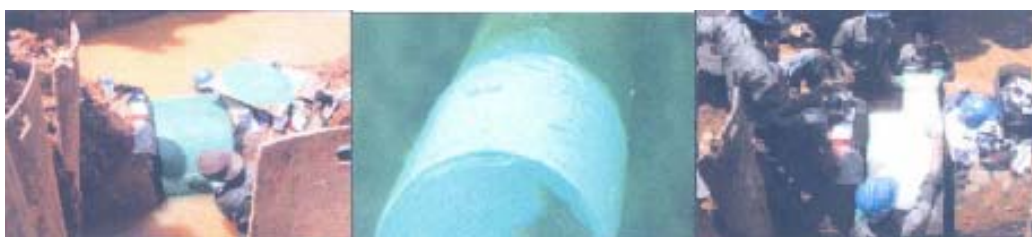
Figura 1.1 – Aplicações de reparo de material composto em ambientes aquáticos
