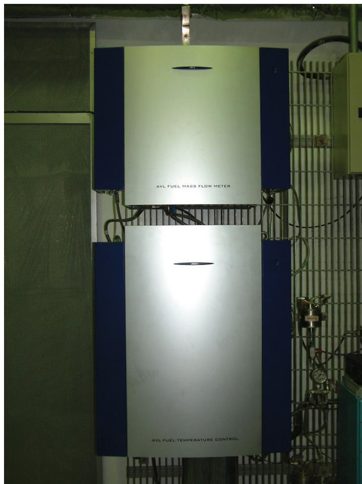
Figura 4.3 – Unidades de condicionamento e medição do consumo de combustível.
