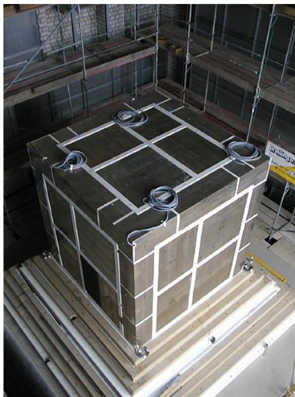
Figura 26 – Câmara blindada BMSR-2 em construção (PTB, Berlim, Alemanha), com a primeira camada de  $\mu$ -metal instalada.
