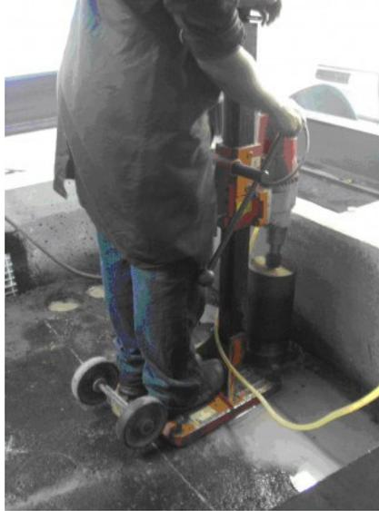
Figura 3.26: Extração de corpos de prova do tanque-teste
