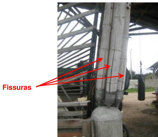
Figura 2- Propagação de trincas em colmos de bambu utilizados como elementos estruturais.
