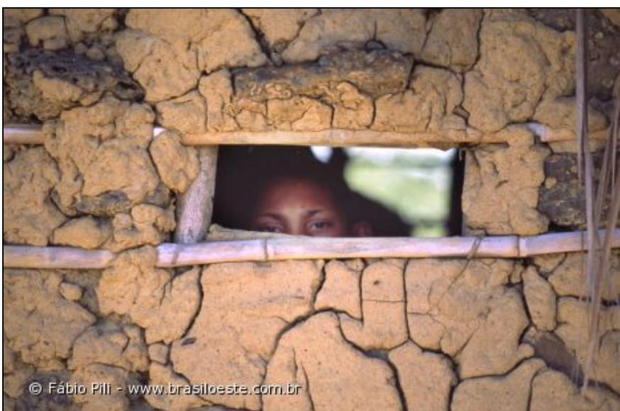
**Fig. 69** - Casa de pau a pique sem reboco. Trincas abertas e perigo à saúde. Jalapão, Tocantins, Brasil, 2005. (fonte: [www.brasiloeste.com.br](http://www.brasiloeste.com.br)).
