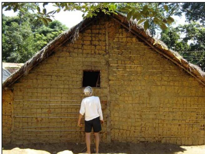
**Fig. 50:** Casa de reza (*Opy'i*). Cobertura em duas águas de fibras vegetais, paredes de pau a pique (bambu, barro e madeira), 2007. (Fonte: Arquivo pessoal).
