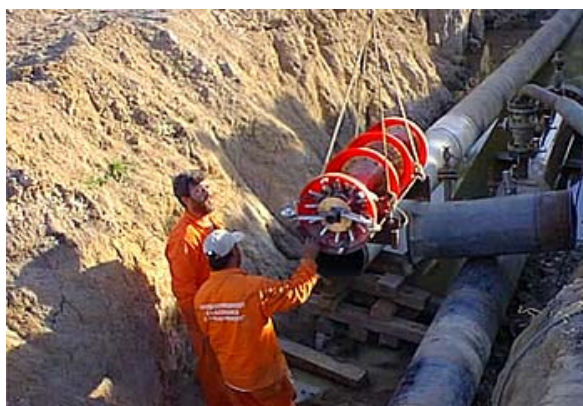
Imagem 4 – Colocação de um PIG dentro de uma tubulação
