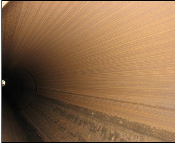
Figura 15 - Visão da parede interna do duto após passagem do Pig Palito
