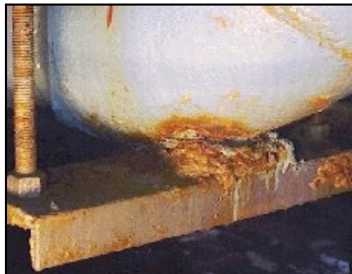
Figura 3 - Corrosão Galvânica
