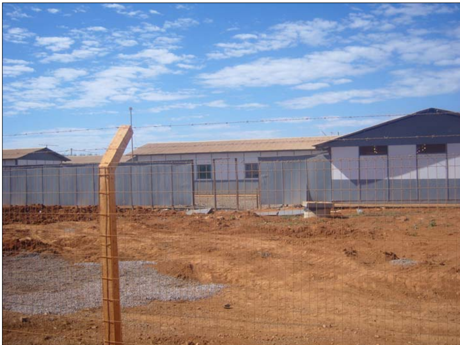
Foto 4 - Residências em construção na planta da Sadia de Lucas do Rio Verde
