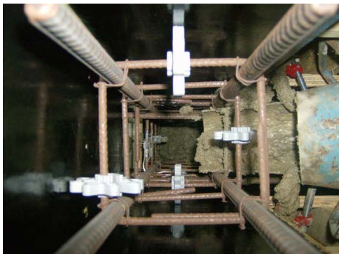
Figura D.13 – Detalhe da 1ª etapa de concretagem do espécime PVx.
