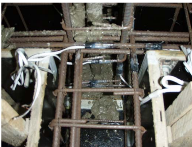
Figura D.14 – Detalhe da 1ª etapa de concretagem do espécime PVxy.
