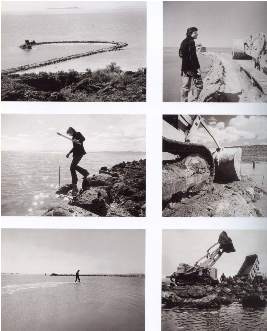
Fig. 32. Spiral Jetty - Construção
