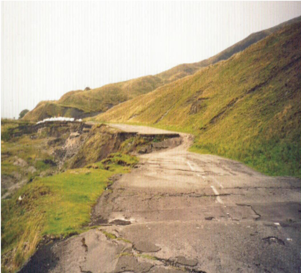
Figura 2.3: Foto da estrada A6187, na Inglaterra, próximo a Castleton. Cisalhamento do solo tornou-a destruída e impossível de se trafegar.
