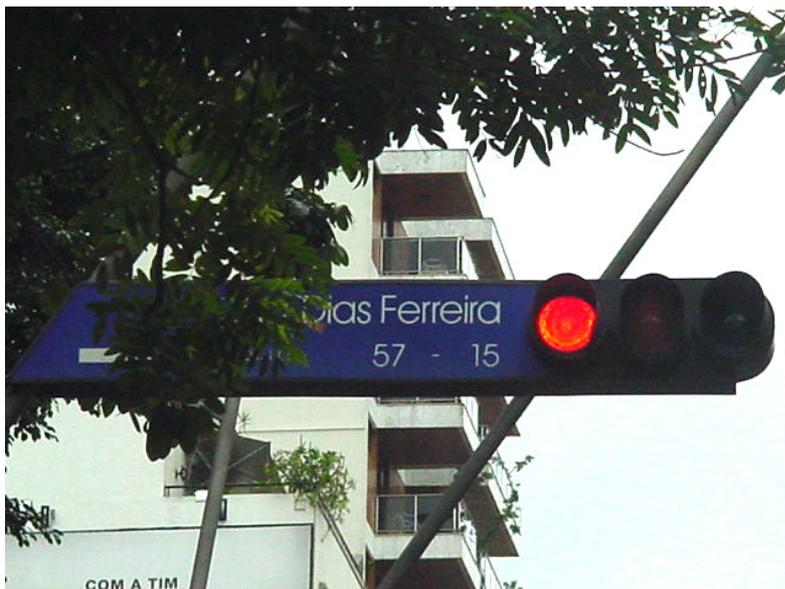
Figura 17 - Grupo focal horizontal com três indicações luminosas e destinado ao fluxo de veículos. A indicação mostrada na foto, através da luz vermelha, é para os veículos pararem antes da linha de retenção - Foto do autor. Local: Av. Ataulfo de Paiva – Rio de Janeiro (RJ).
