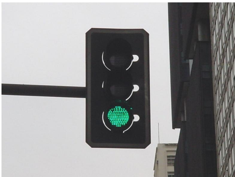
Figura 16 - Grupo focal vertical com três indicações luminosas e destinado ao fluxo de veículos. A indicação mostrada nesta foto, através da luz verde, é para os veículos continuarem o seu caminho - Foto do autor. Local: Av. Presidente Vargas – Rio de Janeiro (RJ).
