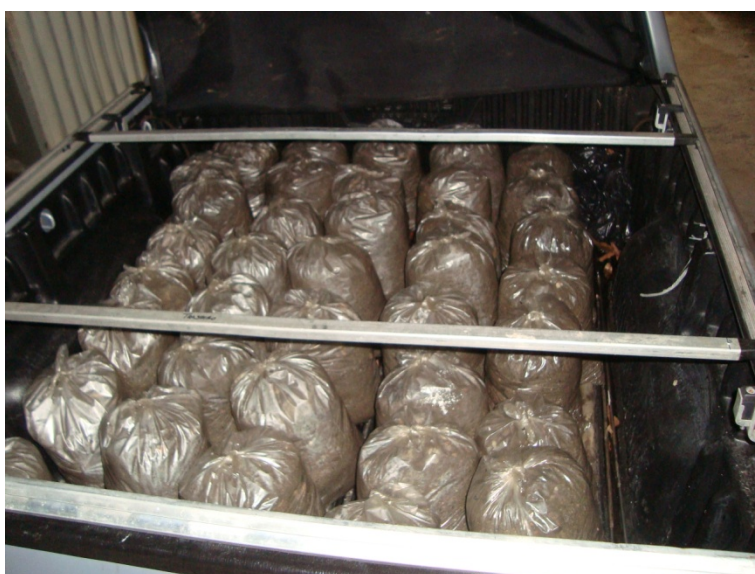
Figura 10 - Acondicionamento e transporte do solo contaminado
