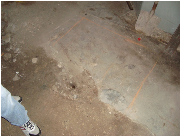
Figura 9 - Demarcação da área para escavação
