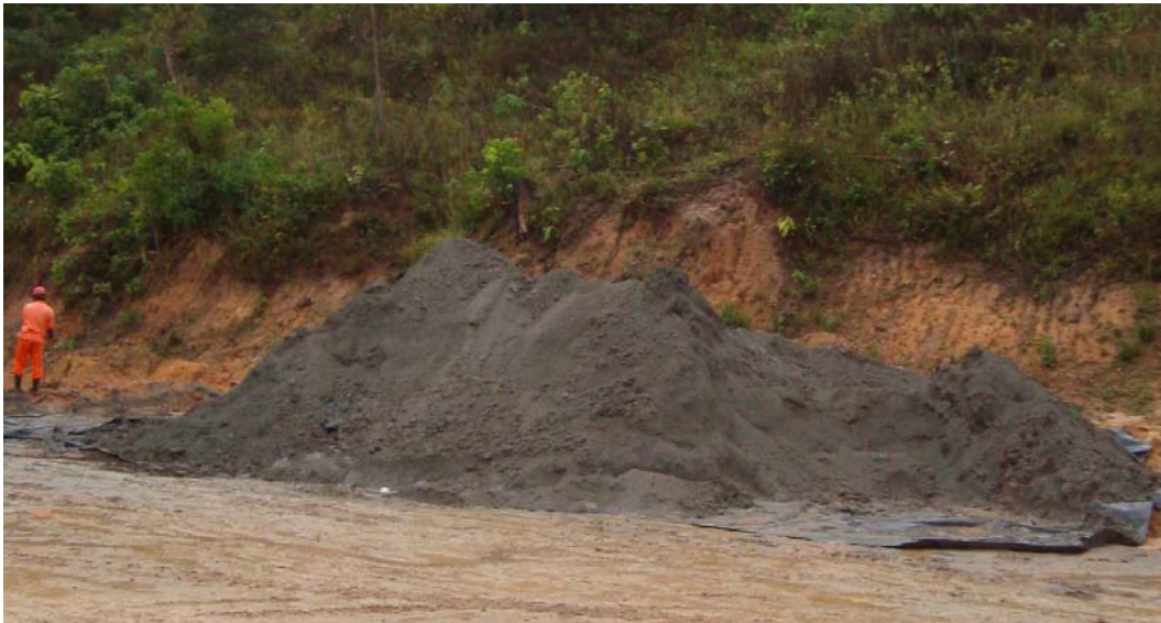
Figura 2-3 – Cascalho de perfuração estocado após processo de perfuração do poço MG-112, Campo de Miranga, Pojuca-Ba.
