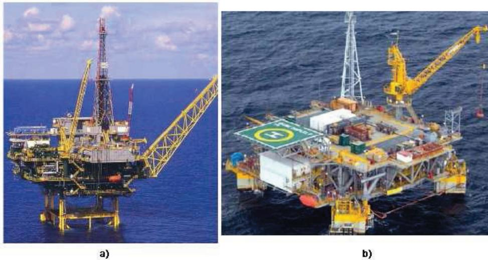
Figura 1.3: Plataformas de petróleo: a) Torre Complacente b) TLP (Fonte:Offshore Technology).
