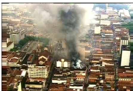
Figura 7 - Incêndio SAARA: enquadramento 3
