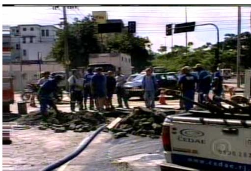
Figura 14 - Trabalhadores da CEDAE durante os reparos
