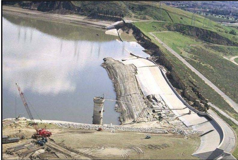
Figura 1.1 - Deslizamento na barragem de San Fernando, em 1971 (EERC, University of California, Berkeley, USA).
