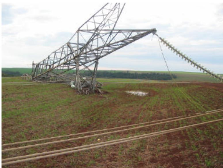
Figura 2.18 – Ruptura de torre na Bacia do Prata causada por tornado
