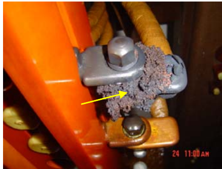
Interligação dos terminais do cabo AT e do comutador de apresentando carbonização, corrosão e fusão
