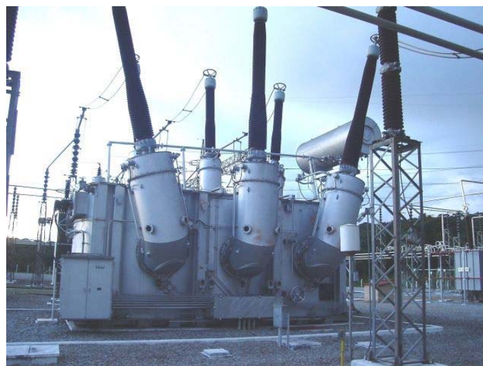
Figura 42 – Autotransformador trifásico
